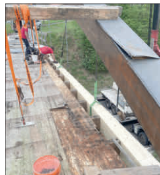
Fachmännischer Austausch der Untergurte an der bestehenden Struktur.
