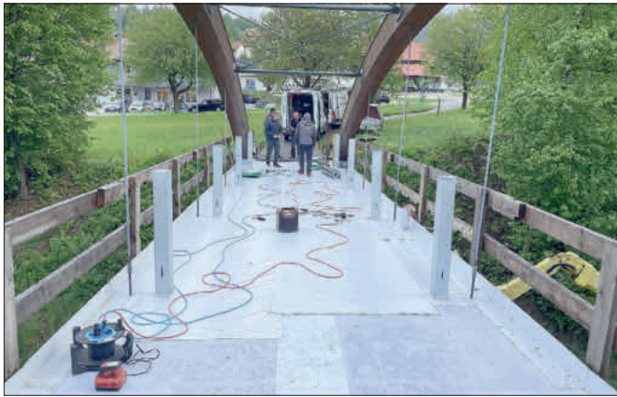
Austausch der Geländerpfosten und mehrlagige Abdichtung der Brückenfahrbahn.
