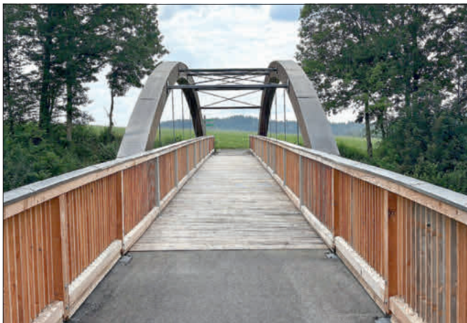
Die sanierte Fußgängerbrücke über die Staatsstraße 2132 ist wieder geöffnet. Spaziergänger, Wanderer und Hundebesitzer können die wichtige Verbindung ab sofort wieder ohne Umwege nutzen.
